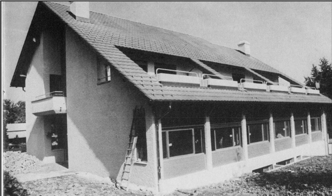
Das neue Kirchgemeindehaus an der Höflistrasse 25.
